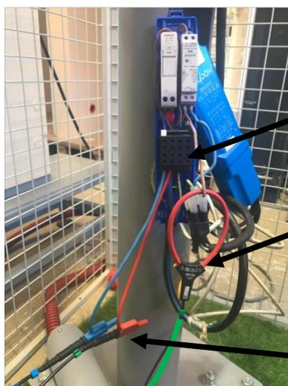
Raccordement de cordons double puits sur le bornier de raccordement des circuits électriques du Mat N°1.
