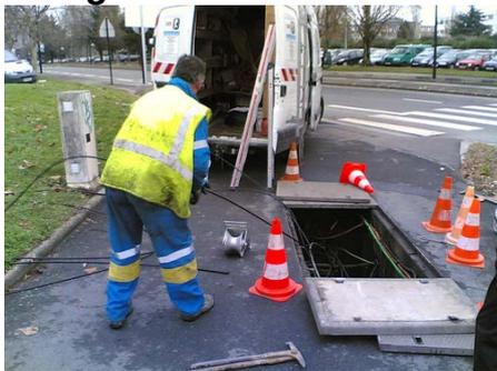
Le tirage est un mode de pose de la fibre optique dans les fourreaux. Cette méthode consiste à faire passer un câble de tirage dans le fourreau afin de pouvoir tirer ensuite le câble optique préalablement accroché. Le tirage ne peut pas se faire sur des distances trop importantes (au delà d'une centaine de mètres ça commence à devenir limite) car cette technique crée un effort de traction sur le câble, et donc un risque de dommages si la longueur (donc le poids) à tirer est trop élevée.
